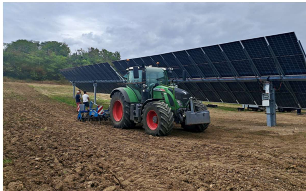
Ombrière démonstrateur de Chadeleuf (63)
